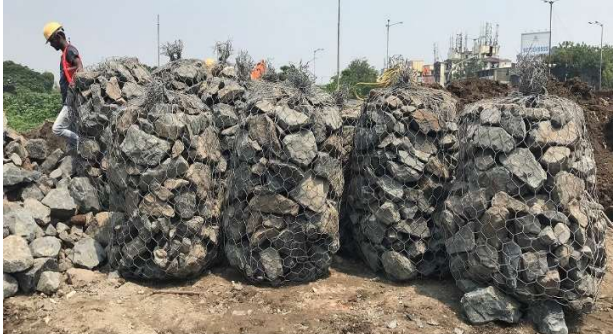
Fig:03. Prefilled Sack Gabion
